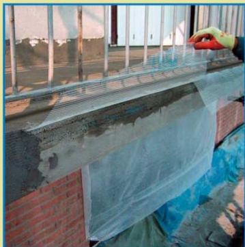
Kouty, rohy a silně namáhané plochy doporučujeme vyztuzit síťovinou ze skelných vláken.
