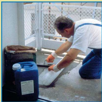
Kouty, rohy a silně namáhané plochy doporučujeme vyztuzit síťovinou ze skelných vláken.
