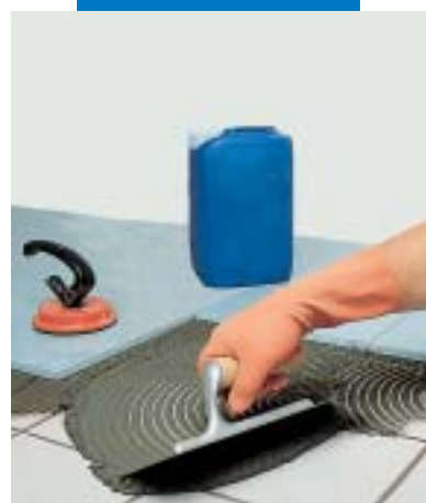
Lepení aglomerátových dlaždic na původní keramickou dlažbu šedým Granirapidem
