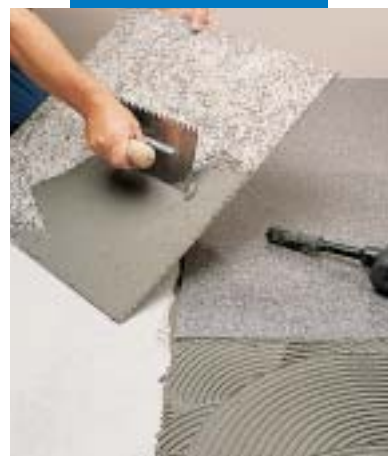
Lepení syntetického konglomerátu šedým Granirapidem
