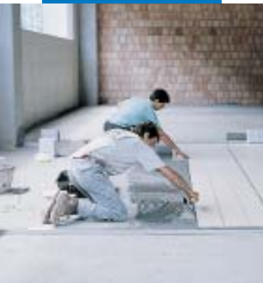
Lepení kameninové dlažby ve výrobních prostorách
