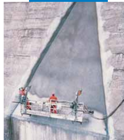
Ukázka strojní aplikace Mapelasticu na stěnu přehrady
