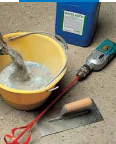
Míchání Mapelasticu mechanickým míchadlem
