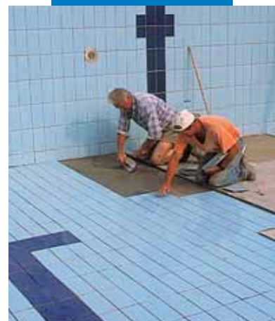
Lepení keramického obkladového materiálu na Mapelastic v bazénu
