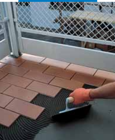
Lepení dlažby Granirapidem na balkon izolovaný Mapelasticem
