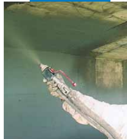
Ukázka strojní aplikace Mapelasticu na most nástřikem
