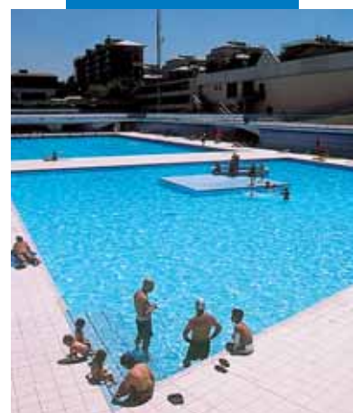
Bazén izolovaný Mapelasticem: Scarioni - centrum volného času - Miláno, Itálie
