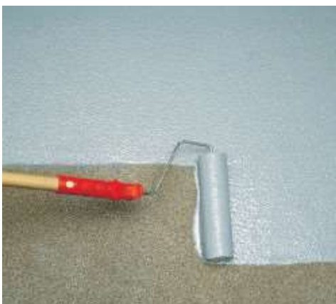
Aplikace Mapecoatu I 24 válečkem
