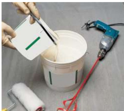
Míchání složky B se složkou A
