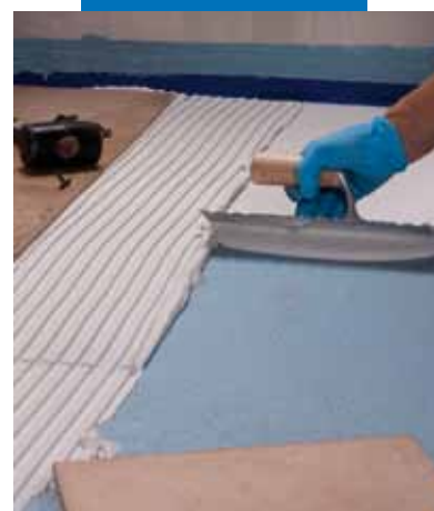
Lepení dlažby na Mapelasticu® AquaDefense
