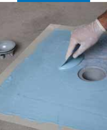
Vložení tkaniny odvodňovací vpusti Drain Vertical do Mapelastic® AquaDefense
