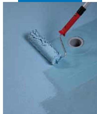
Nanášení druhé vrstvy Mapelasticu® AquaDefense válečkem
