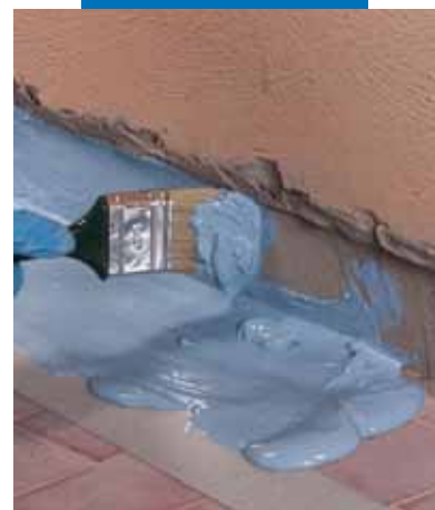
Nanášení Mapelasticu® AquaDefense před instalací Mapebandu ve styku stěna-podlaha
