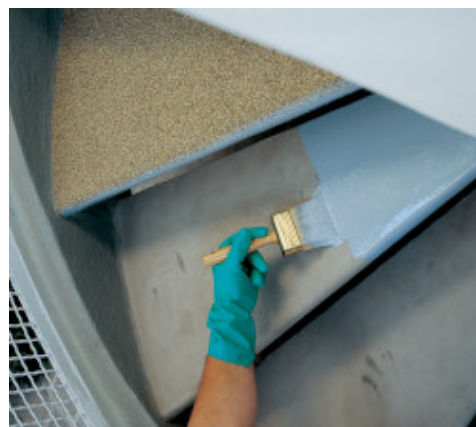
Aplikace Mapecoatu I 24 na beton
