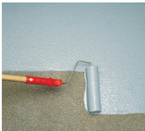
Aplikace Mapecoatu I 24 válečkem
