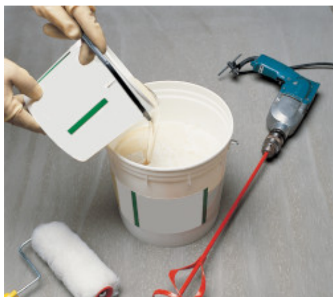
Míchání složky B se složkou A
