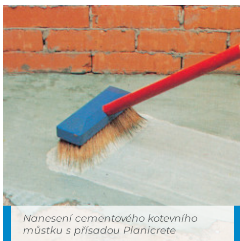
Provádění kotveného betonového potěru s přísadou Planicrete
