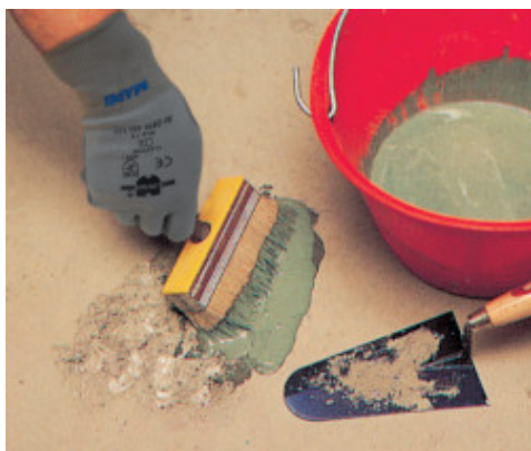
Lokální oprava podlahy: nanášení kotevního můstku
