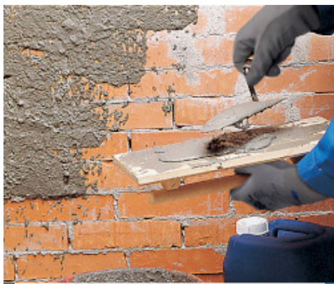
Cementový podhoz s přísadou Planicrete
