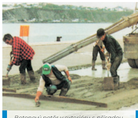
Betonový potěr v exteriéru s přísadou Planicrete. Stavba Vieux Port – Quebec – Kanada
