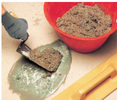
Lokální oprava podlahy: aplikace malty
