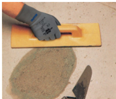
Lokální oprava podlahy: konečné vyhlazení povrchu
