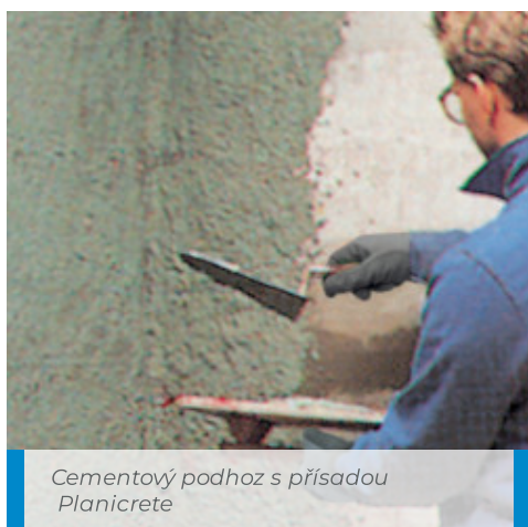
Nanesení cementového kotveního můstku s přísadou Planicrete
