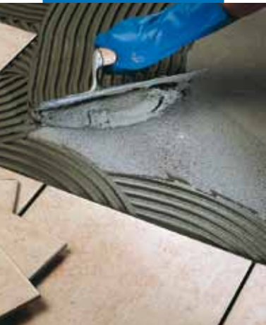
Pokládka jedenkrát pálené dlažby
