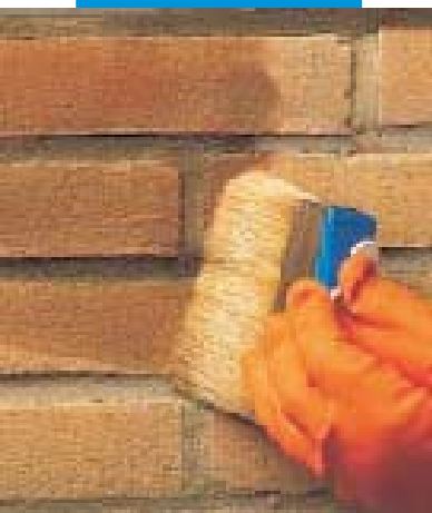
1. Nanášení Antipluviolu S štětkou
