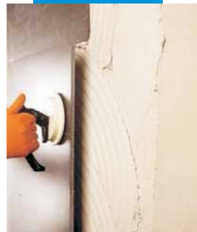
kladení keramické dlažby velkého formátu do Elastorapidu v exteriéru na podklad z betonu
