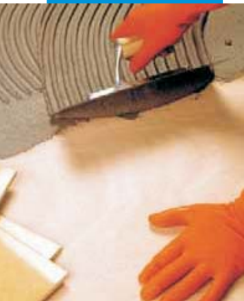
nanášení Elastorapidu zubovou stěrku na cementový potěr
