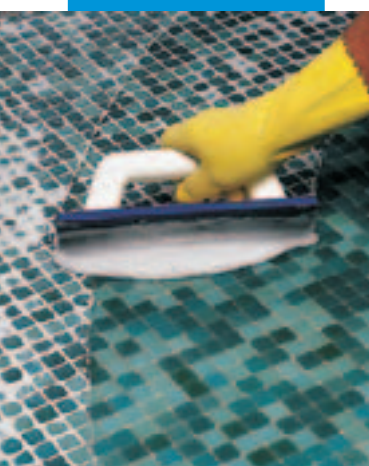
Spárování skleněné mozaiky pomocí Keracoloru FF, smíšeného s Fugolasticem
