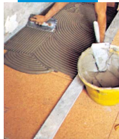
Lepení dlažby Kerabond+ Isolastic na korkové desky
