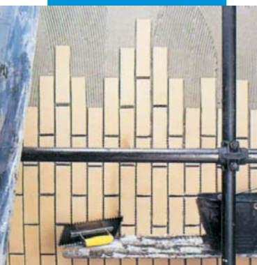
Lepení obkladů v exteriéru (Kerabond + Isolastic)
