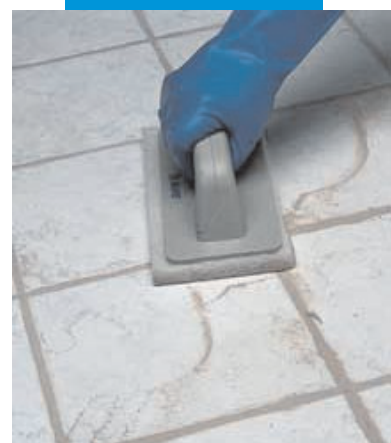
Dokončení povrchu houbou Scotch-Brite®
