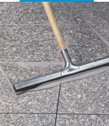
Stěrkování povrchu žulové dlažby stěrkou na násadě
