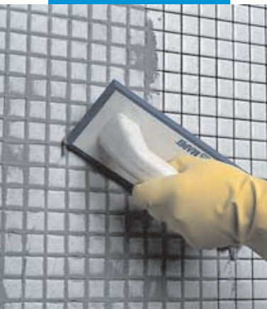
Spárování skleněné mozaiky stěrkou na stěně (v koupelně)
