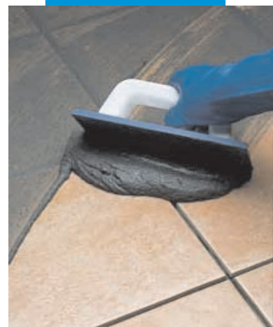
Spárování jednou pálené dlažby stěrkou
