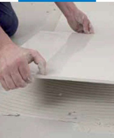
Pokládka keramické dlažby
