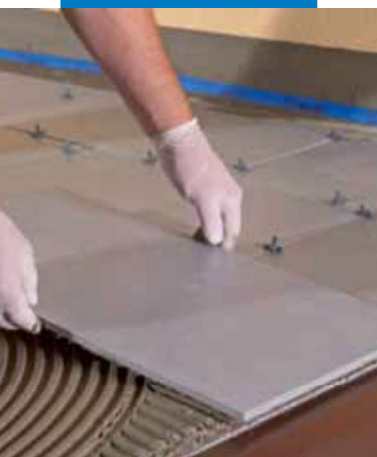
Pokládka keramické dlažby
