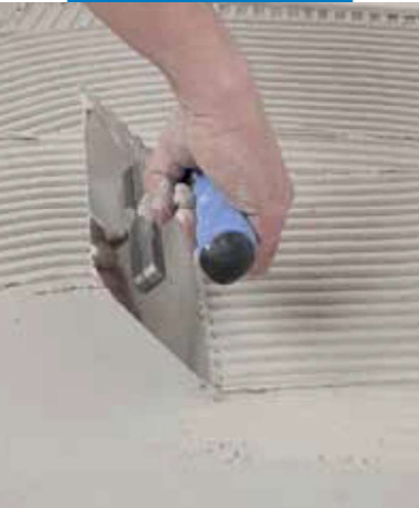
Nanášení Keraflexu Extra S1 zubovou stěrkou
