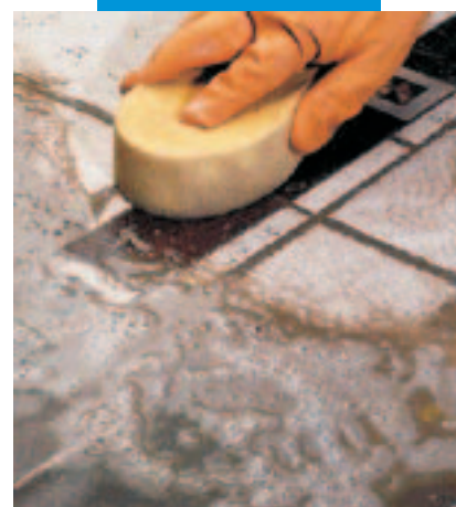
Konečná úprava keramické dlažby s dřevěnými vložkami pomocí houby
