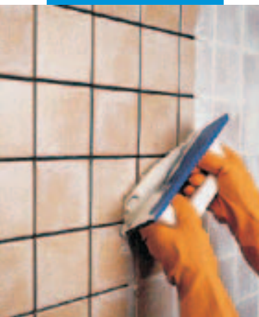
Spárování obkladu ze slinutých dlaždic pomocí hladítka
