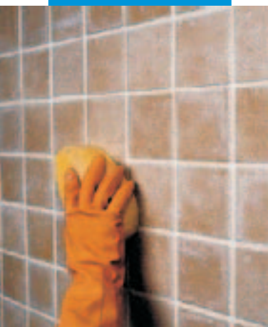
Konečná úprava jedenkrát pálených obkladů pomocí houby
