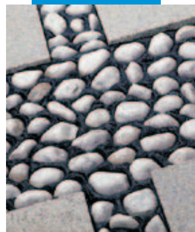
Ukázka spárování ornamentálních kamenů
