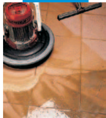
Konečná úprava porcelánové dlažby pomocí elektrického spárovacího a čistícího kartáče
