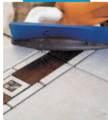
Spárování keramické dlažby s dřevěnými vložkami pomocí hladítka
