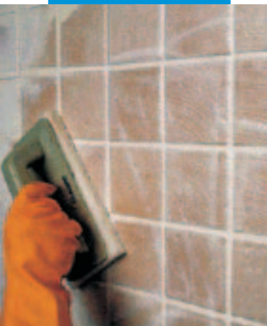
Konečná úprava jedenkrát obkladů pomocí houby Scotch-Brite
