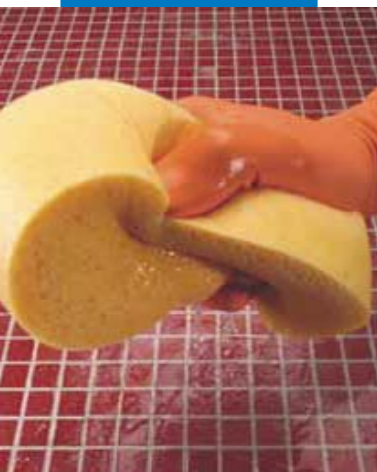
Vlhčení zaspárovaného povrchu před jeho dočištěním
