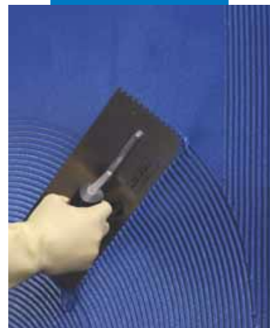
Nanášení Kerapoxy Designu v tmavě modré barvě jako lepicího tme-lu pomocí zubové stěrky
