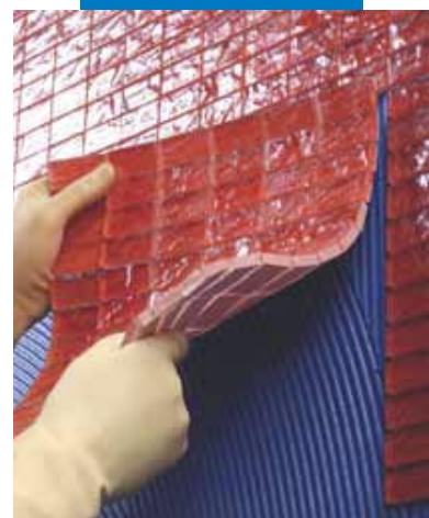
Lepení skleněné mozaiky s Kerapoxy Design
