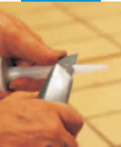
Seřiznutí trysky podle velikosti spáry
