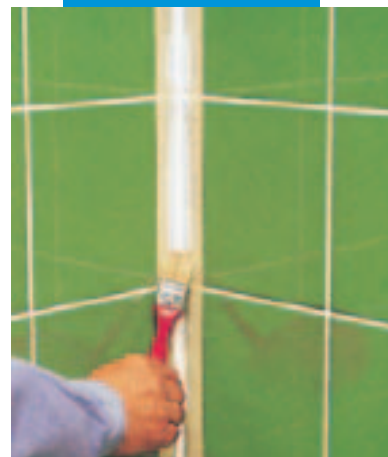
Vyhlazování spáry mýdlovou vodou a malým štětcem
