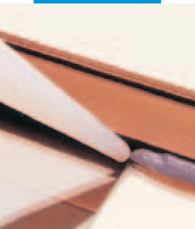
Těsnění hliníkového rámu pomocí MAPESILu AC
