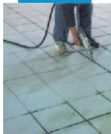
Těsnění keramické dlažby pomocí MAPESILu AC
