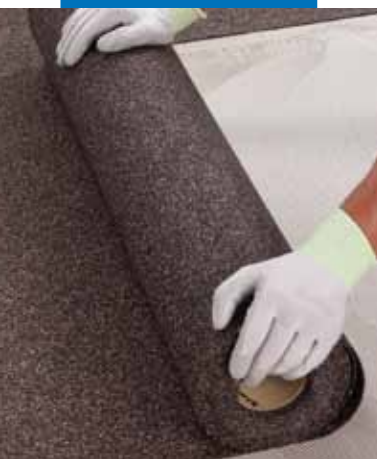
Rozviňte pásy Mapesonicu CR na povrch
