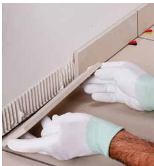
Po obvodu místnosti instalujte soklík tak, aby nedošlo k přímému kontaktu s podlahou
