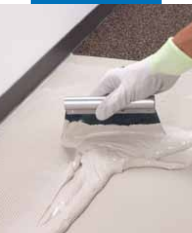
Na dostatečně připravený podklad naneste lepidlo určené k lepení zvukoizolačních pásů
