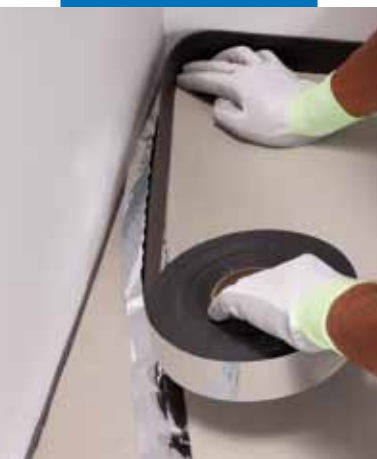
Po obvodu místnosti aplikujte samolepicí pás Mapesonic Strip
