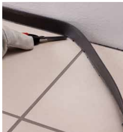
Po vytvrzení spárovací hmoty odřízněte vystupující části Mapesonicu Strip
