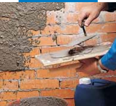
Cementový podhoz s přísadou Planicrete
