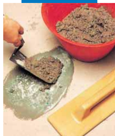
Lokální oprava podlahy: nanesení malty
