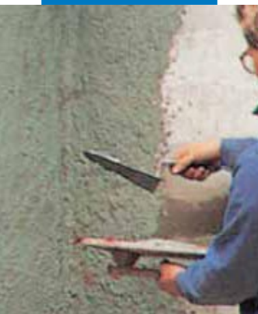
Cementový podhoz s přísadou Planicrete
