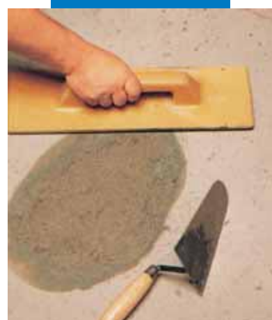
Lokální oprava podlahy: konečné vyhlazení povrchu
