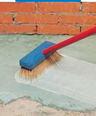
Nanesení cementového kotevního můstku s přísadou Planicrete
