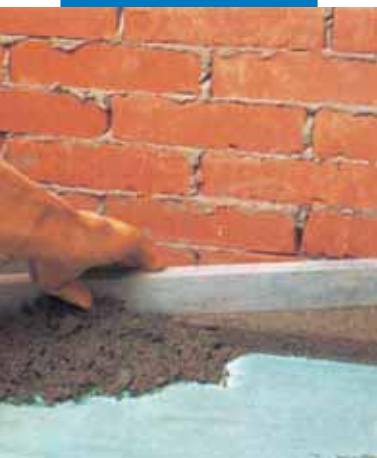
Provádění kotveného betonového potěru s přísadou Planicrete
