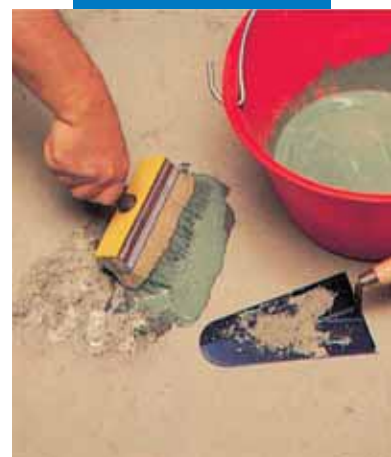
Lokální oprava podlahy: nanášení kotevního můstku
