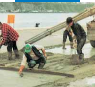
Betonový potěr v exteriéru s přísadou Planicrete. Stavba Vieux Port - Quebec - Kanada
