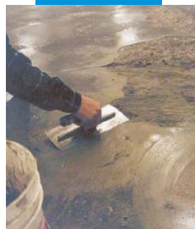
6. Oprava průmyslové podlahy
