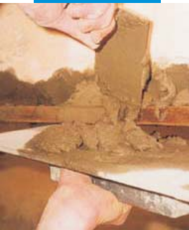
3. Rekonstrukce přední strany betonového plátu na balkoně: nanášení Planitopu 400
