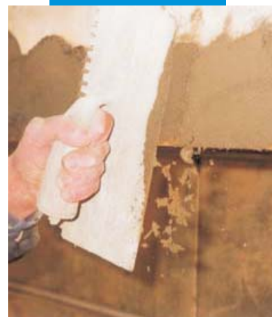
4. Rekonstrukce přední strany betonového plátu na balkoně: dokončování
