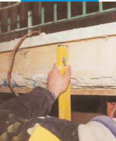
2. Rekonstrukce přední strany betonového plátu na balkoně: připevňování dřevěného bednění
