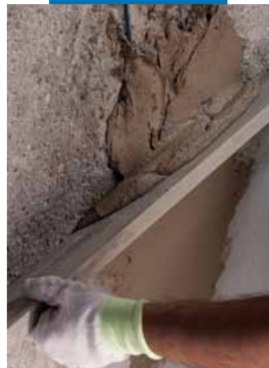
Stahování směsi Planitop Rasa & Ripara hliníkovou latí
