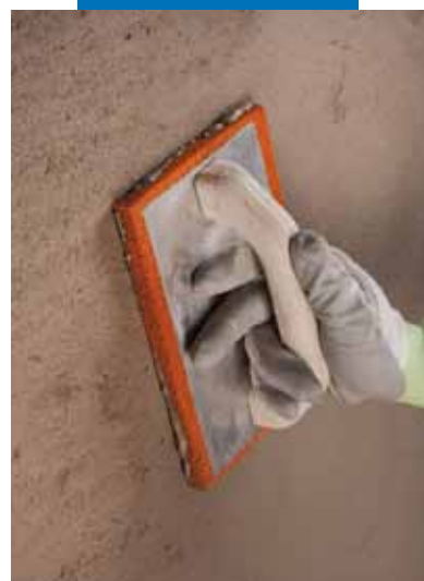
Úprava povrchu Planitop Rasa & Ripara
