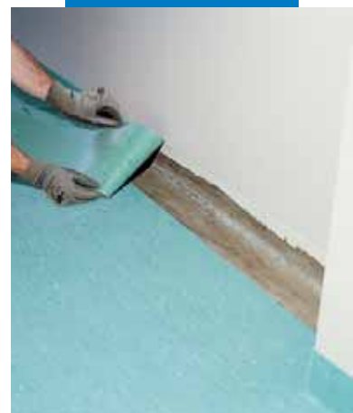
Lepení rohového soklíku PVC
