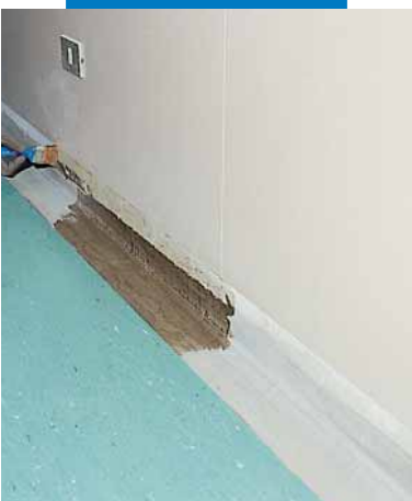
Institut Tumori - Milano - Itálie Lepení rohového profilu PVC Liuni Adesilexem LP
