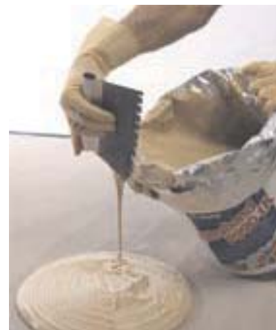
Odstraňování lepidla z okrajů kbelíku pomocí stěrky
